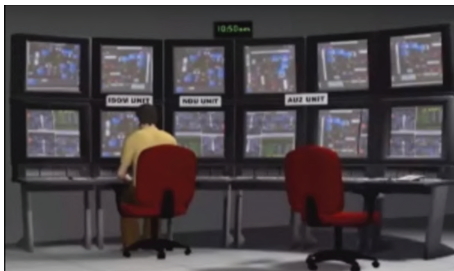
Σχήμα 12.20. Επάνδρωση του κέντρου ελέγχου με έναν χειριστή για τρεις μεγάλες μονάδες
