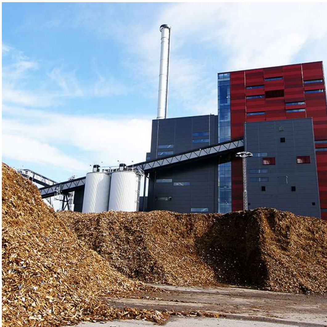
Εργοστάσιο παραγωγής ηλεκτρισμού από βιομάζα
